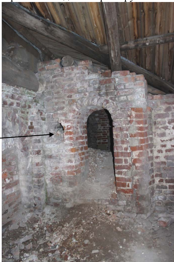
Фото 13. Вход в стрельницу. Пол завален строительным мусором. Слева от дверного проёма – сквозное отверстие для ворота – подъёмного механизма герсы.
