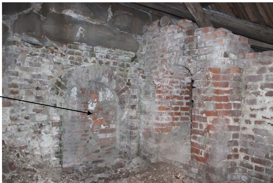
Фото 12. Вид с боевого хода крепостной стены на вход в стрельницу и заложенный кирпичем вход на второй ярус башни.
