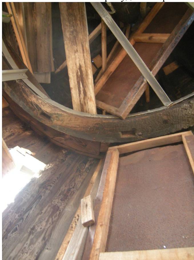
Фото 15. Вид в интерьере смотровой вышки. На кружале видны следы от стоек более ранней конструкции вышки меньшего диаметра.
