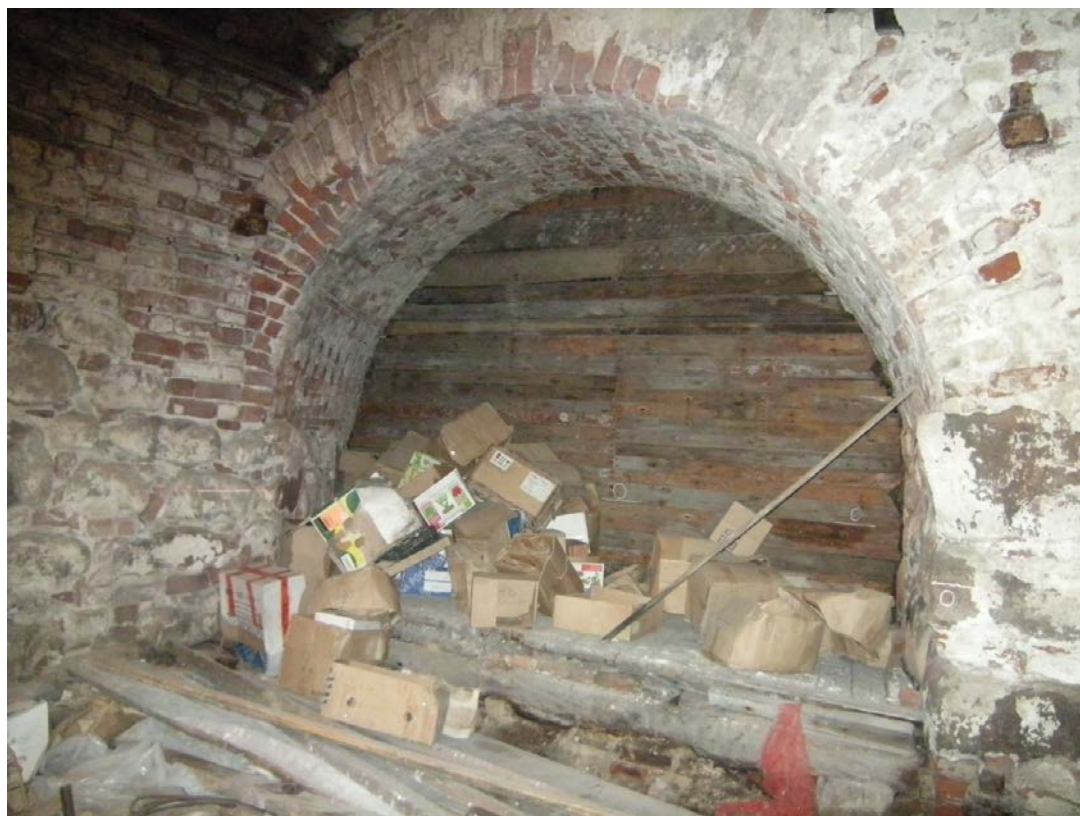
Фото 20. Арочный проём бывшего проезда через башню в монастырский двор. За деревянной обшивкой – кирпичная стена пристроенного здания. По краям проёма видны сохранившиеся поставы ворот. При реставрации планируется закрыть нишу воротами, подобными историческим.
