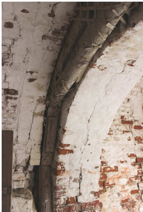
Фото 9, 10. Элементы каркасной перегородки вставлены в нишу для опускающей металлической решётки – герсы.
