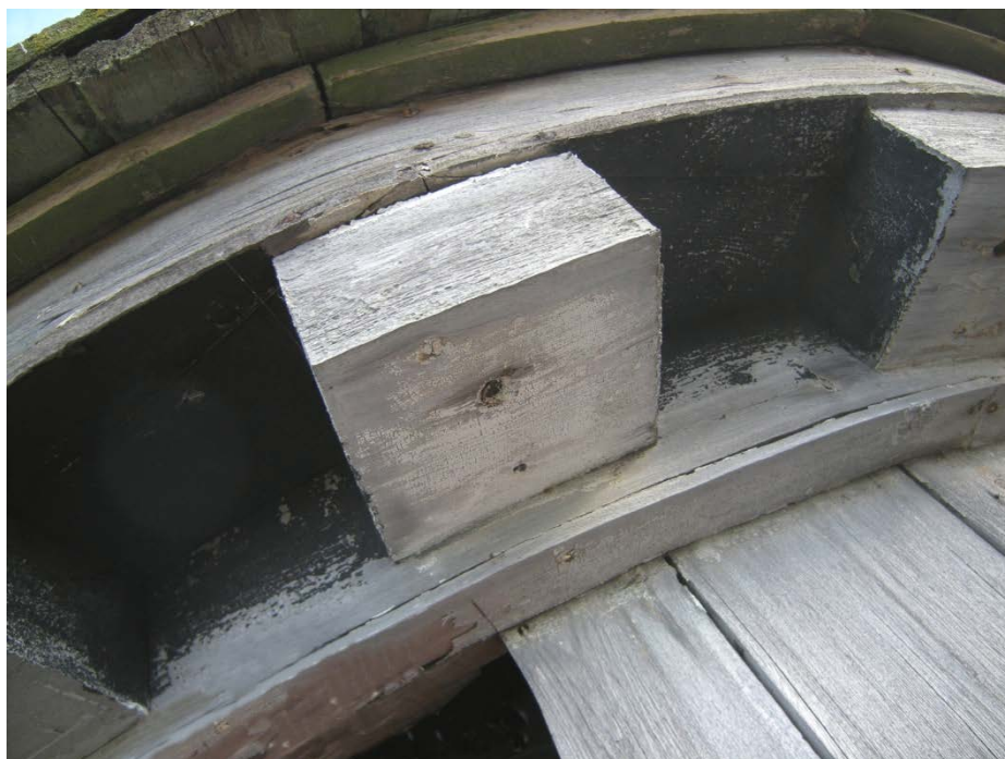
Фото 16. Сухарики карниза купольного покрытия вышки.
