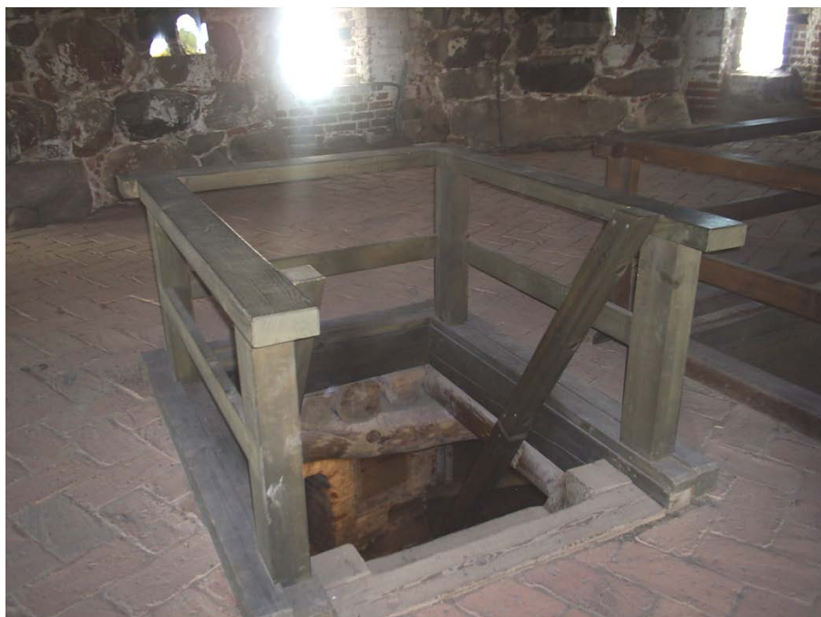
Фото 18. Аналог решения ограждения лестничного проёма в перекрытии и покрытия пола кирпичом на четвёртом ярусе башни.
