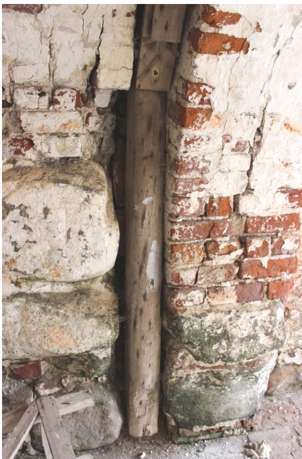
Фото 9, 10. Элементы каркасной перегородки вставлены в нишу для опускающей металлической решётки – герсы.
