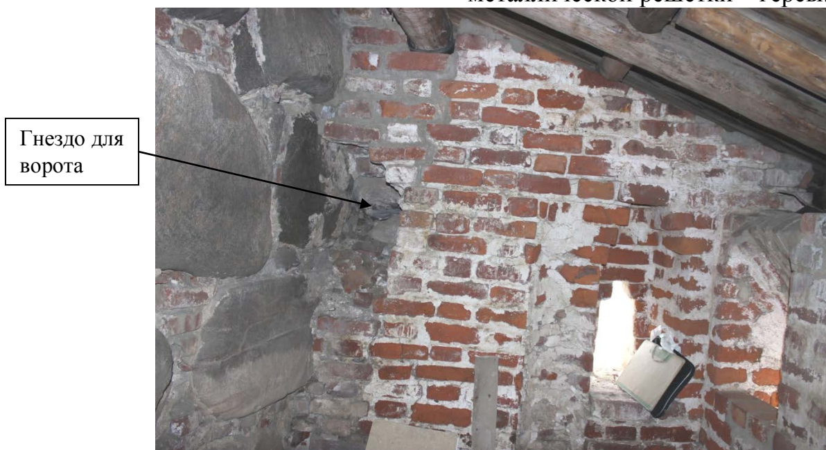
Фото 11. Интерьер стрельницы. В кирпичной стене гнездо для ворота – подъёмного механизма герсы.
